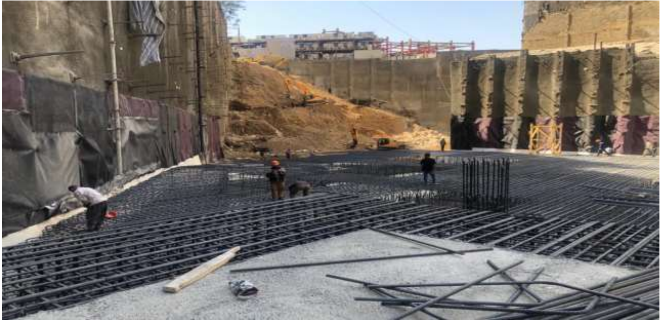
اجرای عملیات آرماتوربندی فونداسیون - خرداد ۱۴۰۰
