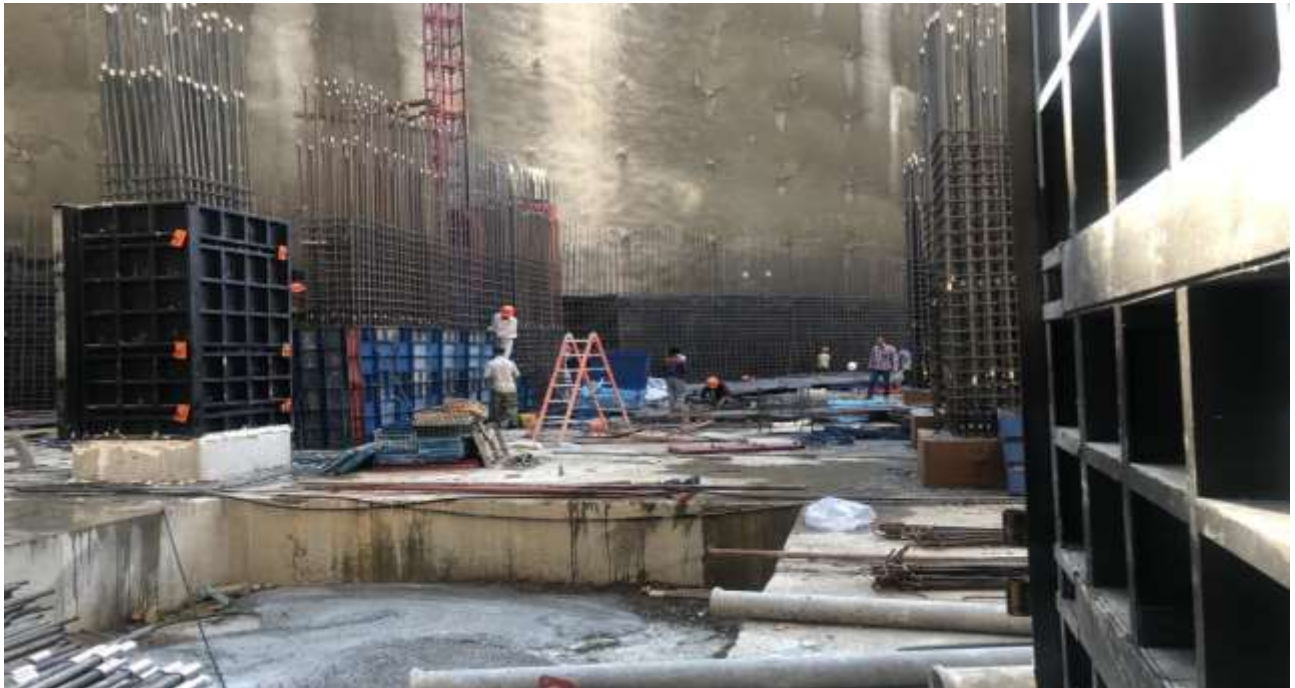
اجرای عملیات آرماتوربندی و قالب بندی ستون ها - خرداد ۱۴۰۰
